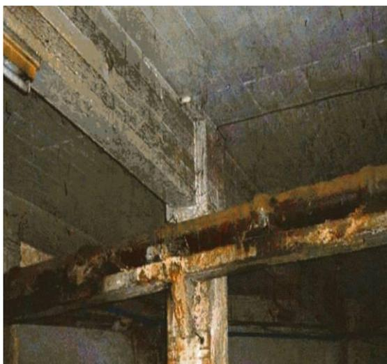
Ha resultado ser el ataque químico más común sobre el hormigón expuesto que se ha detectado durante las inspecciones, más acusado en las edificaciones costeras de Vigo, Coruña y Ferrol.
