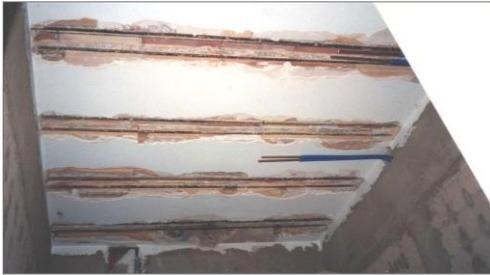
En España, la inspección técnica de edificios, como área específica, arranca en Barcelona con el primer colapso parcial de un edificio en la calle Cadi en noviembre del año 1990, asociado al uso del cemento aluminoso en las viguetas prefabricadas.
