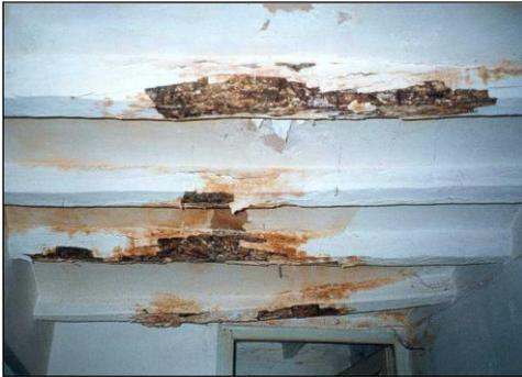
Igualmente, las viguetas de madera al ser vulnerables ante la humedad, se dejaban ventiladas o se cubrían con ceras o pinturas permeables.
