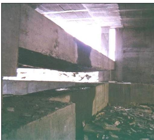
Otro grupo de aparición de daños es el que se debe a una mala previsión del plan de cimbrado y descimbrado, especialmente relevante con losas macizas o reticulares. En estos casos, el forjado en proceso de endurecimiento, debido a la transmisión de cargas desde los forjados superiores a través de los puntales, puede llegar a rebasar la carga total para el que se estimó, siendo esta causa de una deformación remanente.
