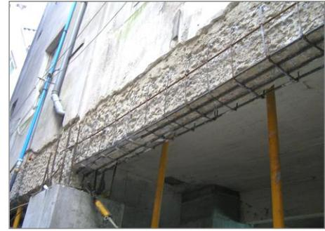
En la mayoría de los trabajos realizados, la operación se ha limitado a un picado superficial del hormigón, el saneado de las armaduras y rehacer el recubrimiento; todo ello sin necesidad de apeos de importancia.
