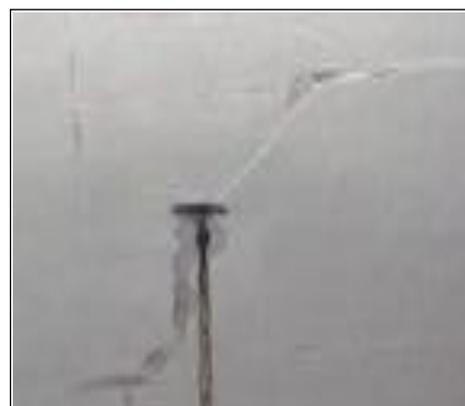
Se han generado así fisuras longitudinales y paralelas a las viguetas, tanto en el revestimiento de la cara inferior como en el solado superior:
