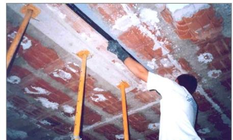
Al mismo tiempo hay que aclarar que, en la mayoría de los casos, la reparación de los daños visibles (fisuración de tabiquerías, pavimentos, etc.) no conlleva la solución del problema de origen, como es el caso de la deformación excesiva del forjado causada por un canto insuficiente.
