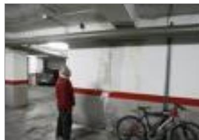
La reacción de los iones sulfato se produce con el aluminato tricálcico del cemento en presencia del agua dando el sulfoaluminato tricálcico, que es la estringita o sal de Candlot, que acaba cristalizando y aumentando hasta 2,5 veces su volumen, lo que genera una fuerte expansión y una posterior desagregación del hormigón. Los daños están en función del tipo de cemento, solubilidad del sulfato, temperatura, permeabilidad del hormigón, etc.
