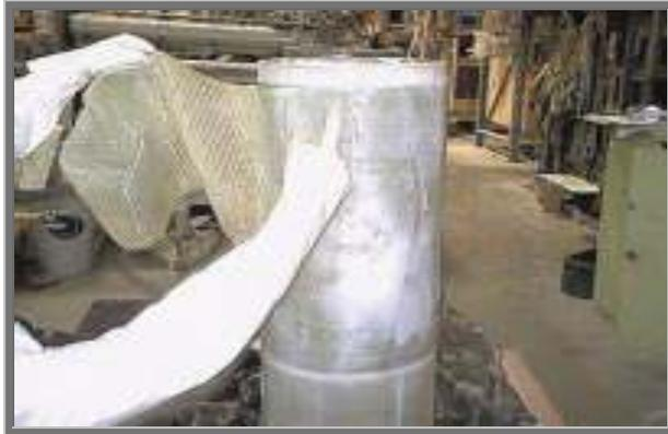
*Figura E.5: Demostración de aplicación de refuerzo de fibra de vidrio.*
