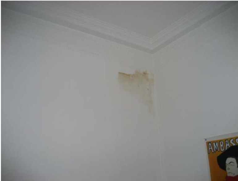
Foto 3. Mancha puntual de humedad.
