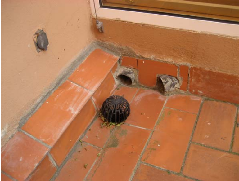
Foto 4.- Detalle sumidero y salida tubos bajo pérgola.
