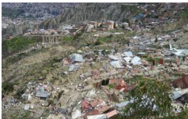
Figura 1.6. Infraviviendas afectadas por deslizamiento de tierras, en la aglomeración de la Paz (Bolivia).
